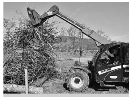
Biocentrum Zahájka – budování plazníku.
