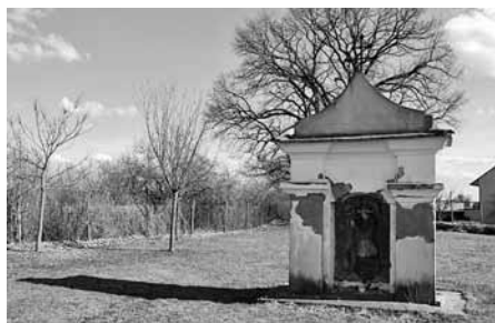
Poklona sv. Barbory před zahájením opravy.
